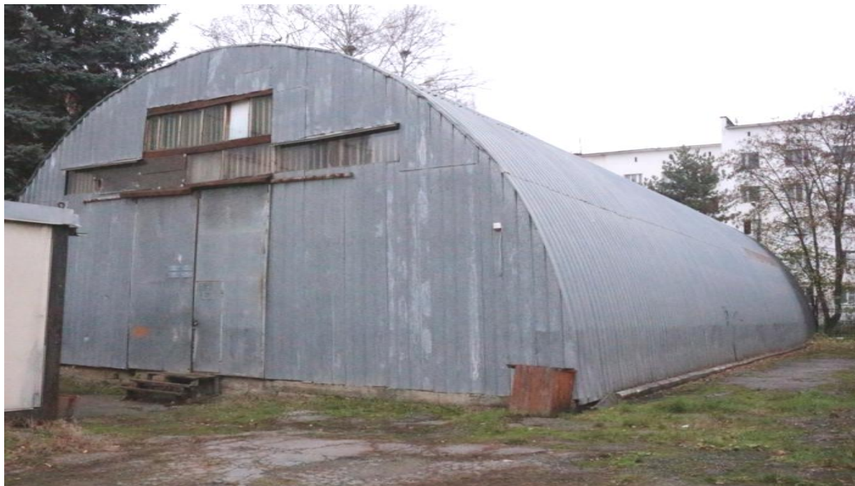
Ангар-Спортзал (Лит.Г5) – год постройки 1984г.
