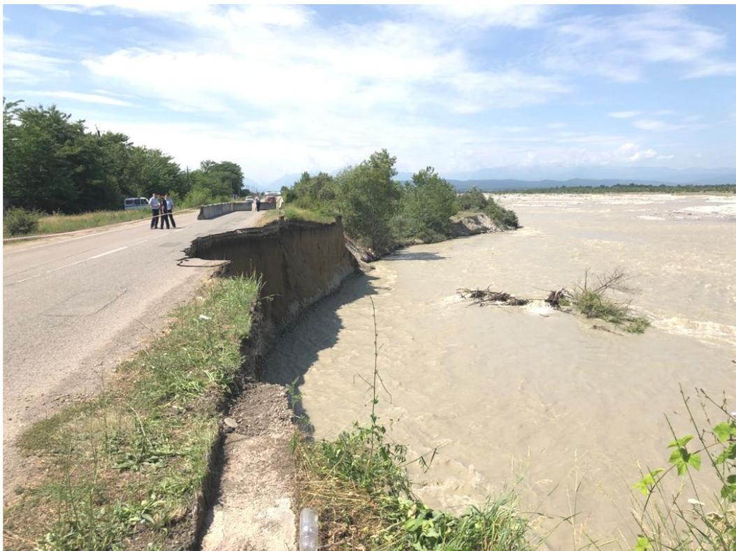
**Рисунок 1.** Размыв автомобильной дороги вдоль реки Черек
