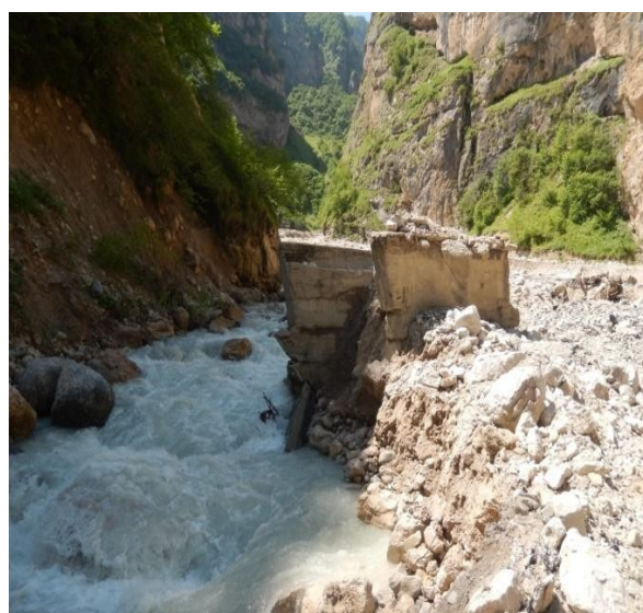
Рисунок 4 – Место размыва верхнего моста по руслу р. Псыгансу (фото ОЭИ ВГИ)
