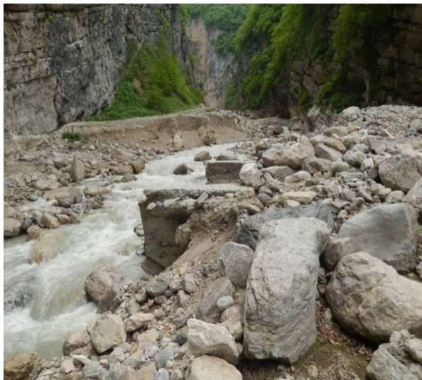
Рисунок 5 – Место размыва нижнего моста по руслу р. Псыгансу (фото ОЭИ ВГИ)
