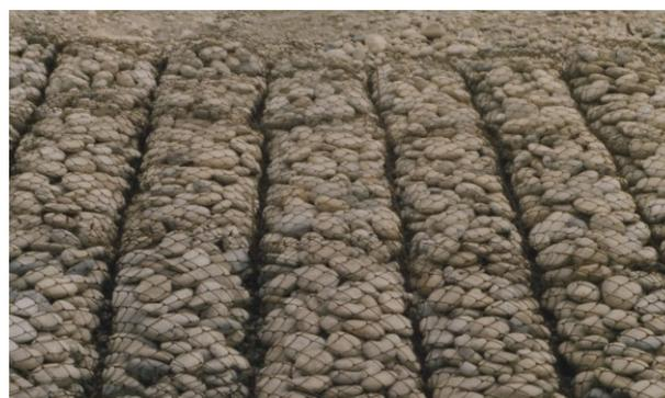
**Рисунок 5** – Откосное крепление дамбы из полуцилиндрических габионов, построенное на реке Черек в Кабардино-Балкарской республике
