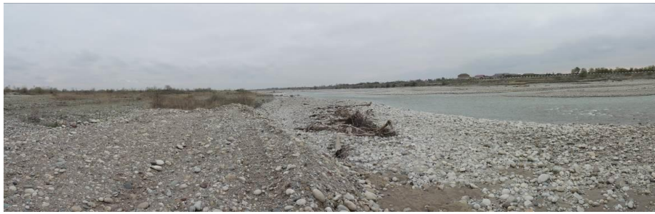
Рисунок 3 – Насыпная валунно-галечниковая дамба на левом берегу реки Баксан: а – вид вверх по течению, б – вид вниз по течению
