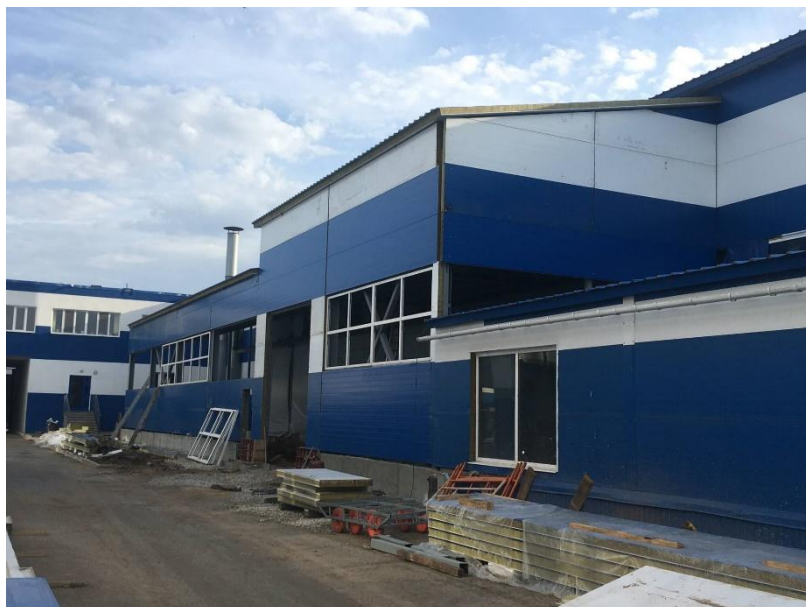
Рисунок 1 – Складское помещение из сэндвич-панелей
