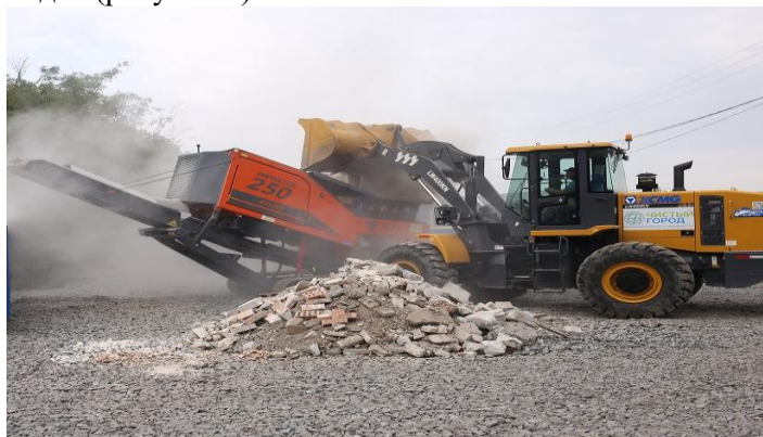
Рисунок 1 – Утилизации строительного мусора
