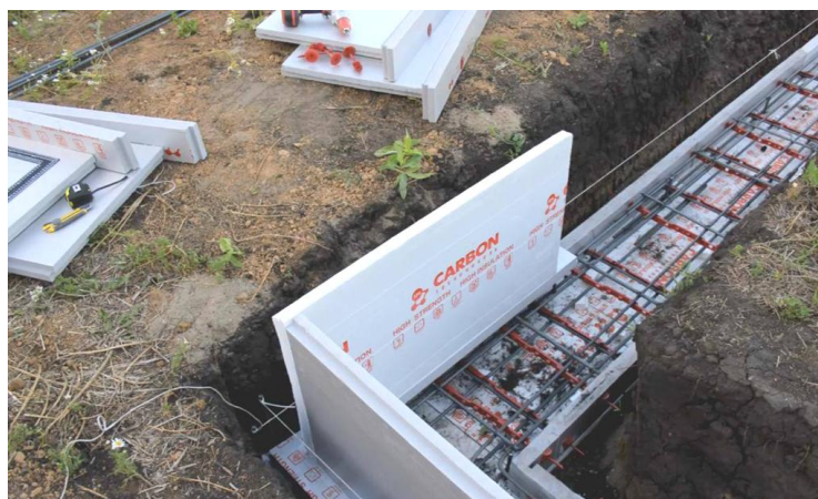
Рисунок 3 – Сборка несъемной опалубки
