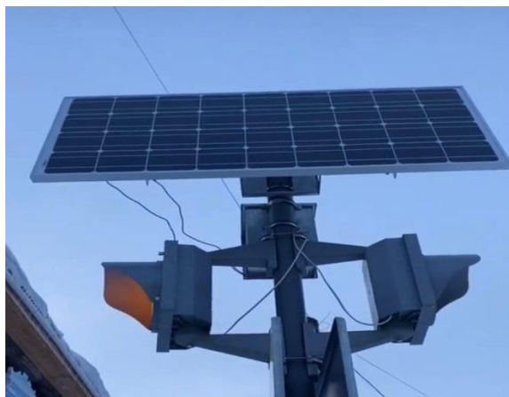
Рисунок 1 – Использование фотоэлектрической станции в нерегулируемых пешеходных переходах [3]
