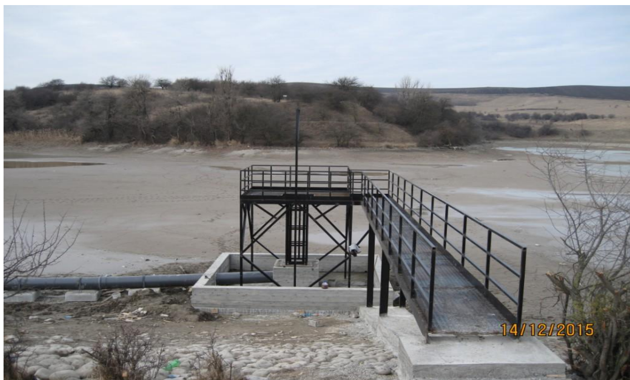
Рисунок 1 - Специальное водозаборное сооружение в период строительства
