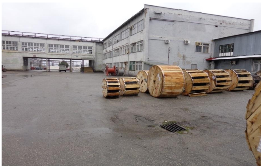
Рисунок 1 – Водоприемный приямок с решеткой
