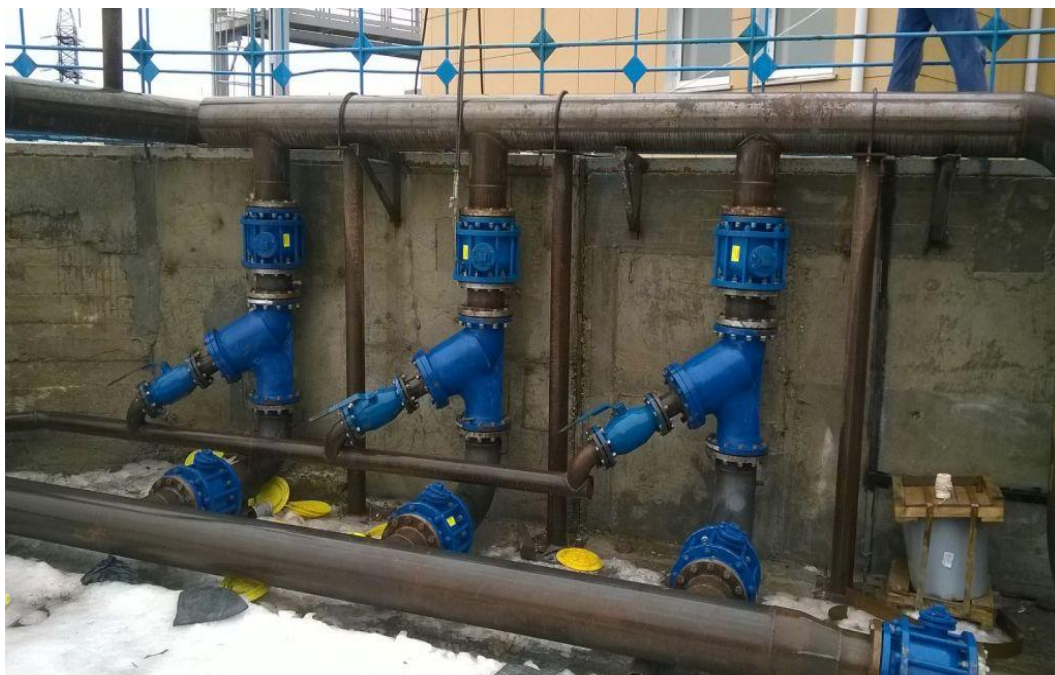
Рисунок 2 – Блок фильтров в период строительства
