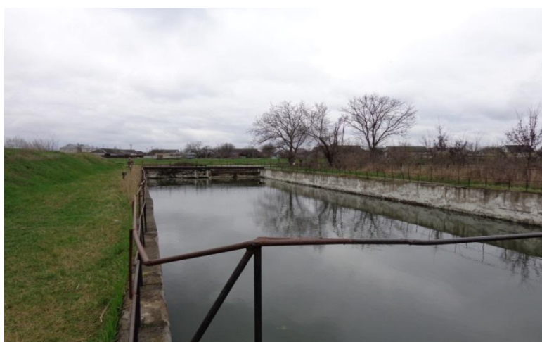
Рисунок 8 - Очистные сооружения ливневых сточных вод – ж/б отстойник
