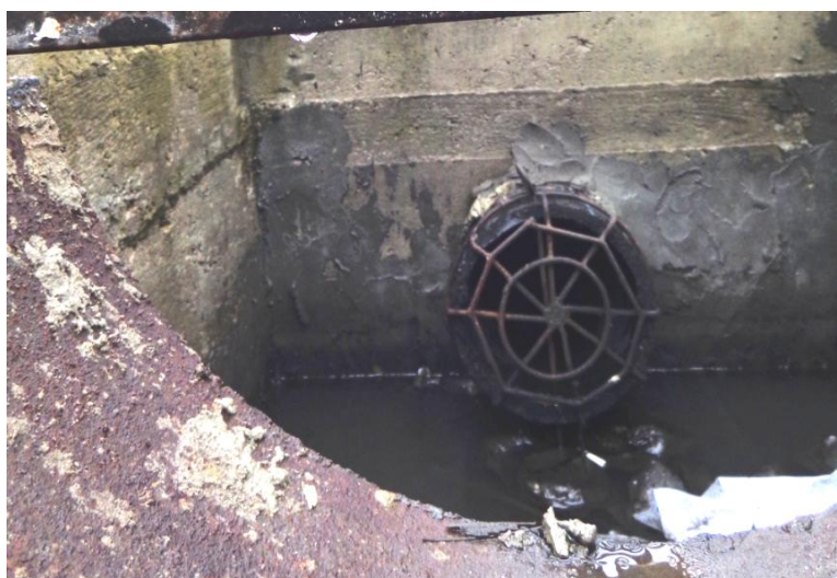
Рисунок 5 – Вертикальная решетка на приемной трубе в приемке
