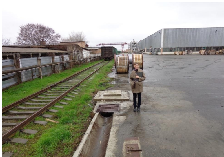
Рисунок 4 – Водосборный лоток с приемком и колодцем
