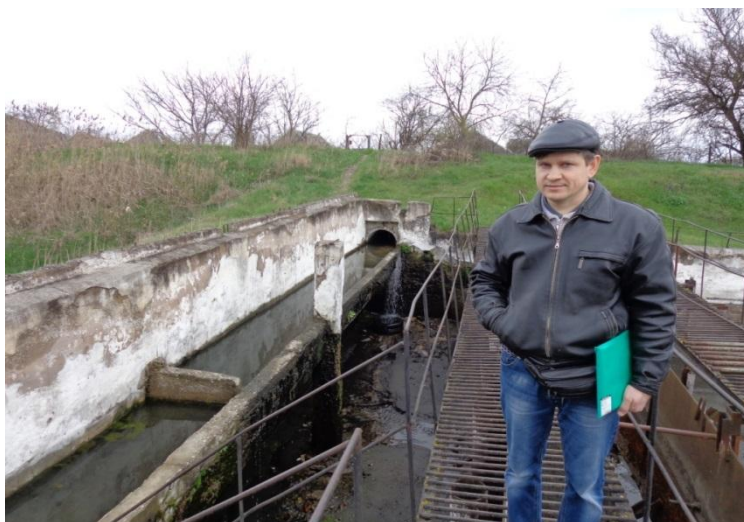
Рисунок 7 – Ввод ливневого коллектора в очистные сооружения, приемный распределительный лоток в отстойнике
