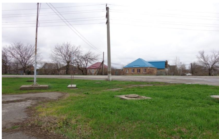
Рисунок 6 – Смотровой колодец на ливневом коллекторе
