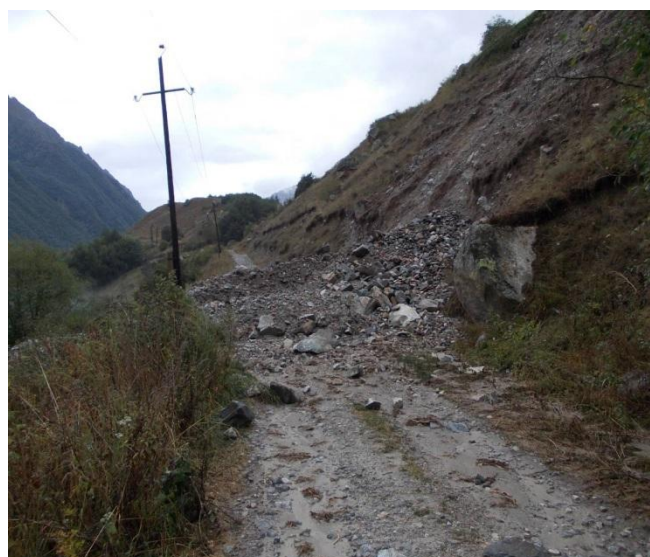
Рисунок 4- Селевой желоб на склоне после сошедшего селя (№4) и перекрытая автодорога селевой массой. Фото Анаева М.Т. 25.08.2019г.
