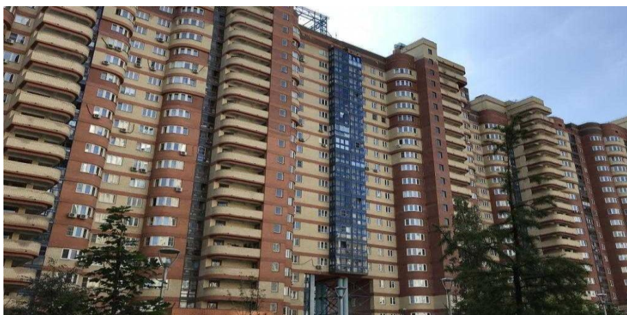
Рисунок 2 – Современный многоквартирный городской жилой дом
