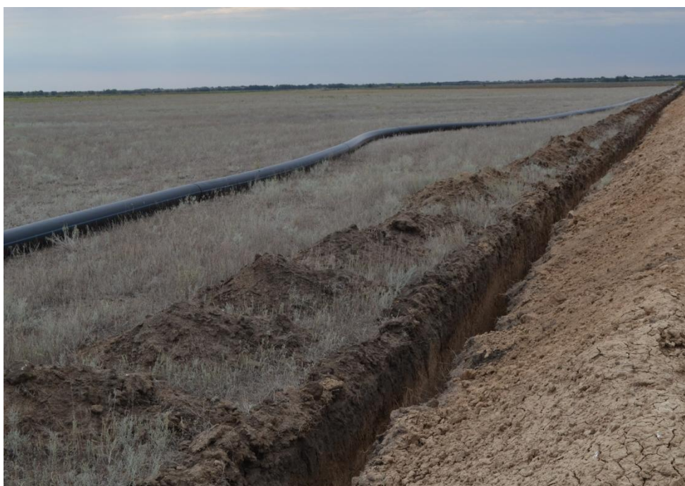
Рисунок 2 – Укладка полиэтиленового трубопровода оросительной системы в траншею
