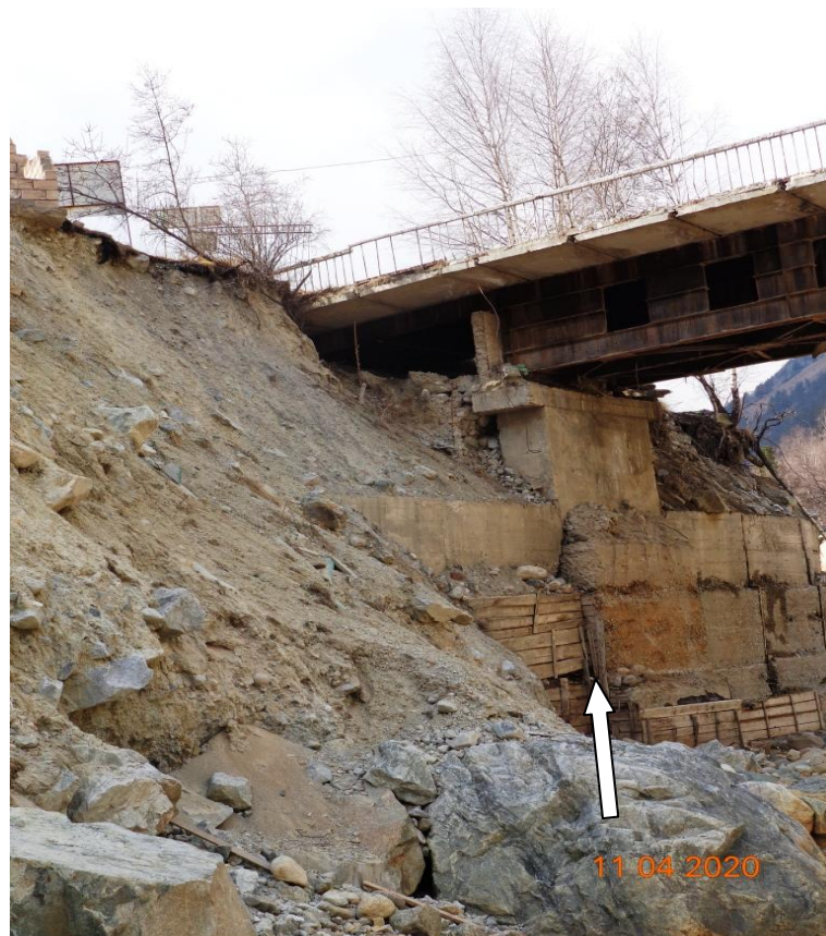
Рисунок 4 – Левобережная верхняя часть моста. Стрелкой показана потенциальная «призма обрушения»
