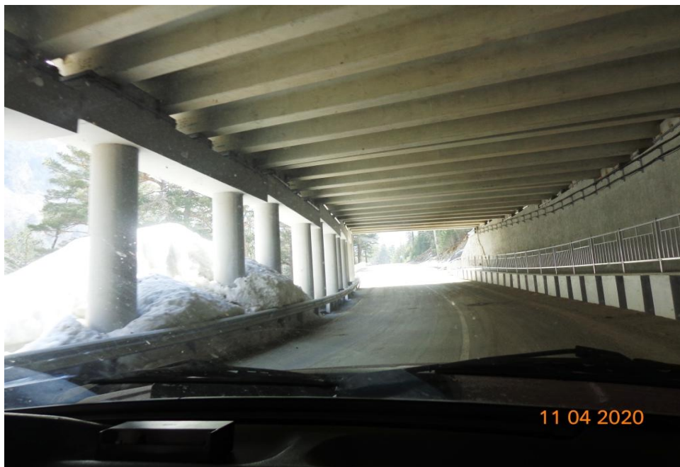
Рисунок 1 – Лавинно-селезащитная галерея 2019 года постройки, расположена перед а/л «Щхельда». Слева под карнизом покрытия видны остатки от последней весенней лавины, сошедшей в марте 2020 года
