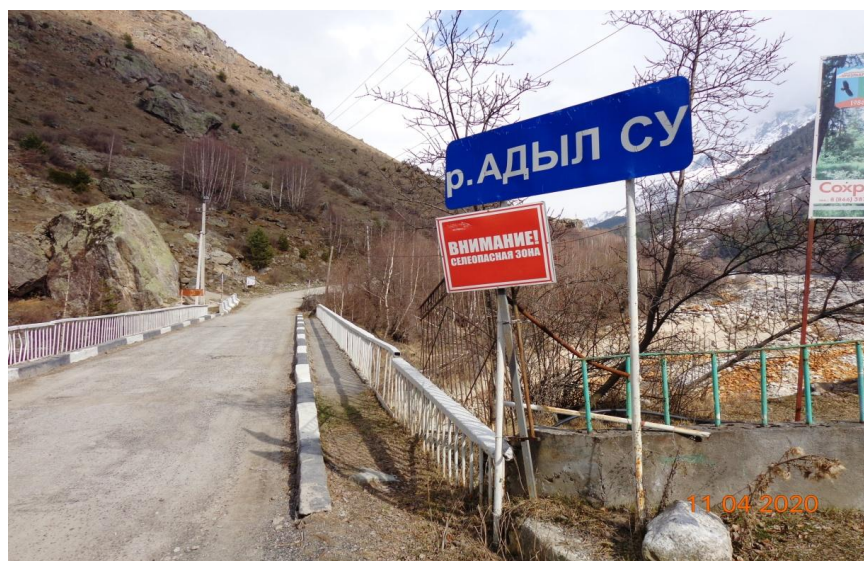
Рисунок 1 – Мост через реку Адыл-су с предупреждающим знаком о селевой угрозе
