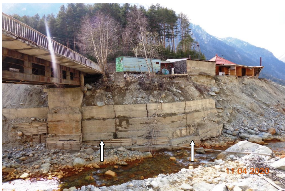
Рисунок 6 – Вид на левый берег в нижней части моста
