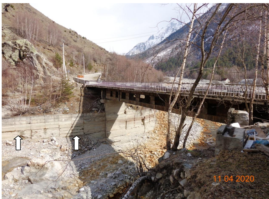
Рисунок 7 – Вид на правый берег в нижней части моста
