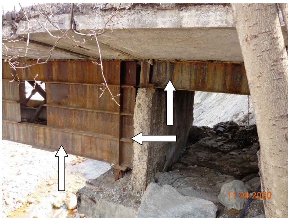
Рисунок 8 – Левобережные опорные конструкции автодорожного моста
