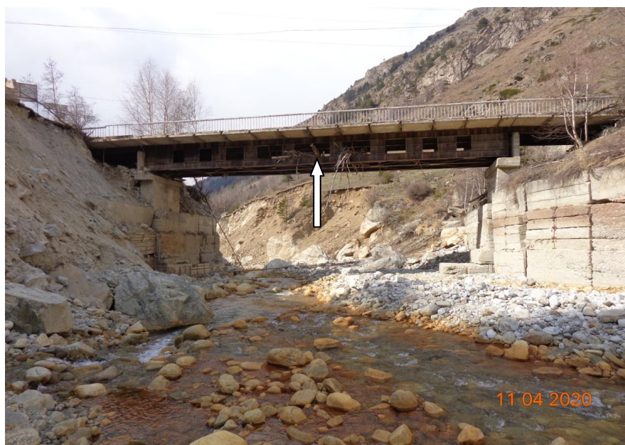
Рисунок 2 – Общий вид на автомобильный мост через реку Адыл-су с русла
