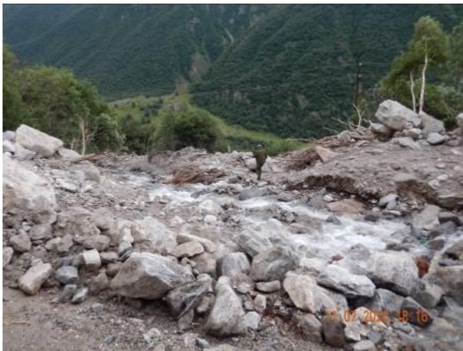
Рисунок 3 – Отложения крупных валунов в русле р. Урель-суу ниже автодороги
