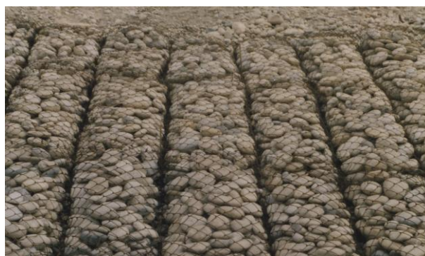
Рисунок 5 – Откосное крепление дамбы из полумонолитных габионов, построенное на реке Черек в Кабардино-Балкарской республике
