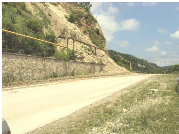
**Рисунок 1** – Характерное состояние откосов на горных дорогах
