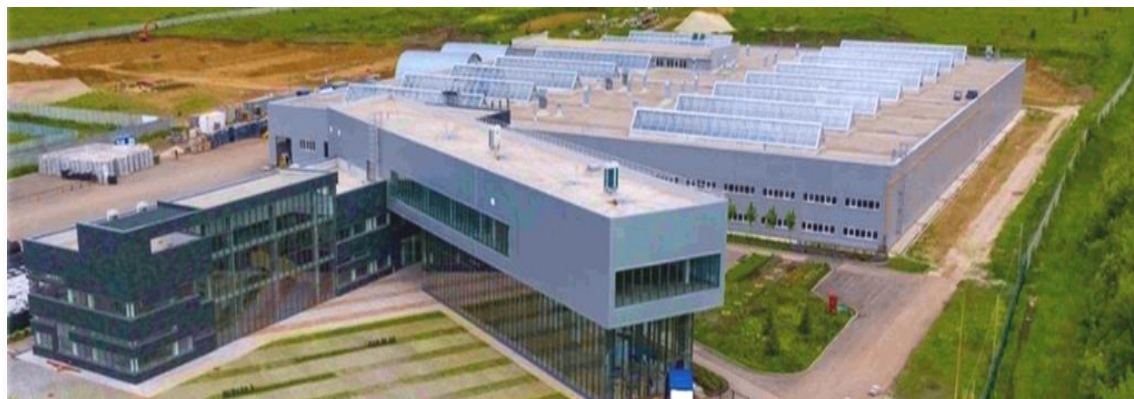
Рисунок 1 – Новый завод по производству системы машин «Туман» ООО «Пегас-Агро» (2022 г.)
