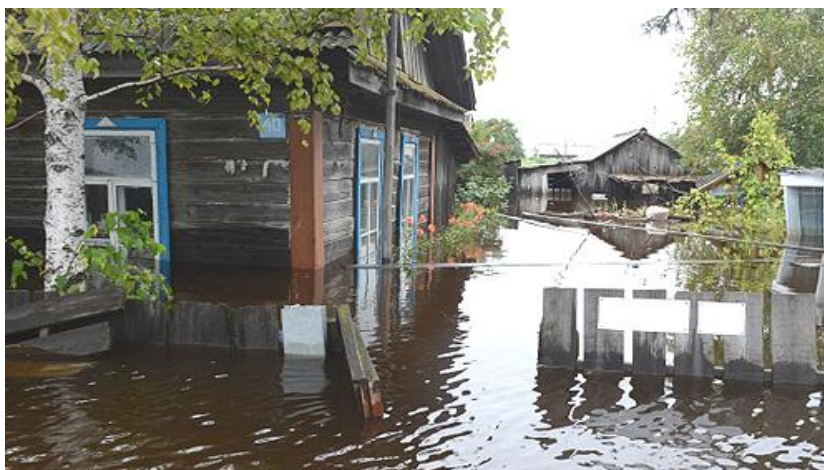
Рисунок 1 – Затопленные дома в селе Мазаново Мазановского района
