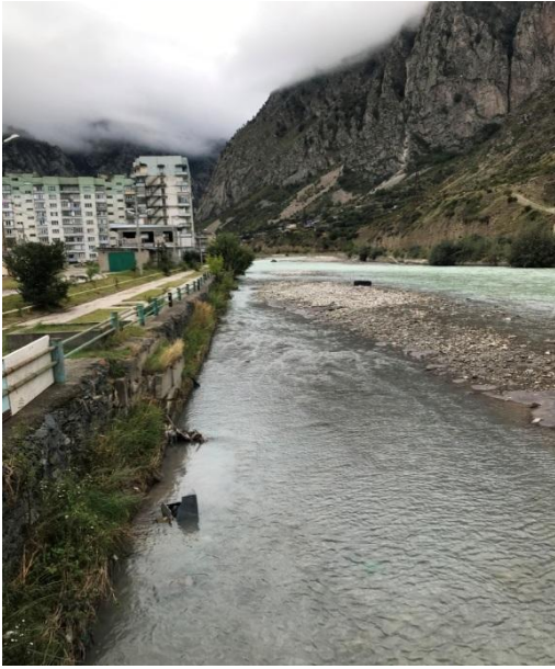
Рисунок 3 – Образование новых накоплений речных наносов в русле реки, меняющих направление водного потока к левому берегу – в направлении дамбы хвостохранилища №1
