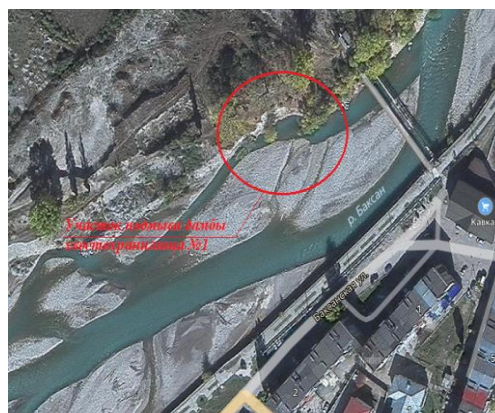
Рисунок 2 – Участок русла реки Баксан в зоне аккумуляции речных наносов и селевых масс в месте подмыва (размыва) откоса дамбы хвостохранилища №1 с обнажением тела складированных здесь отходов обогатительной фабрики ТВМК
