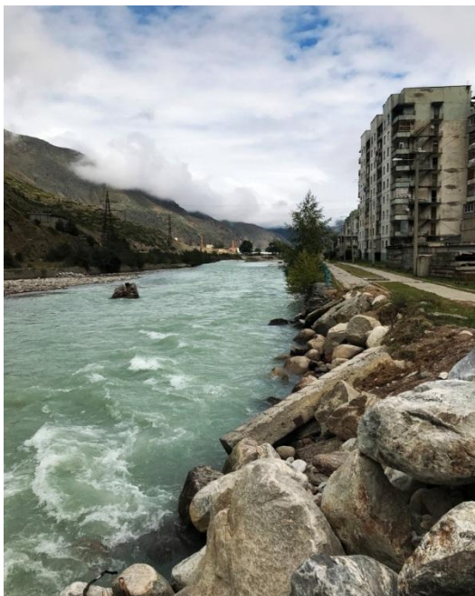
Рисунок 7 – Место разрушения правобережной защитной бетонной стены. Проведены аварийные берегоукрепительные работы
