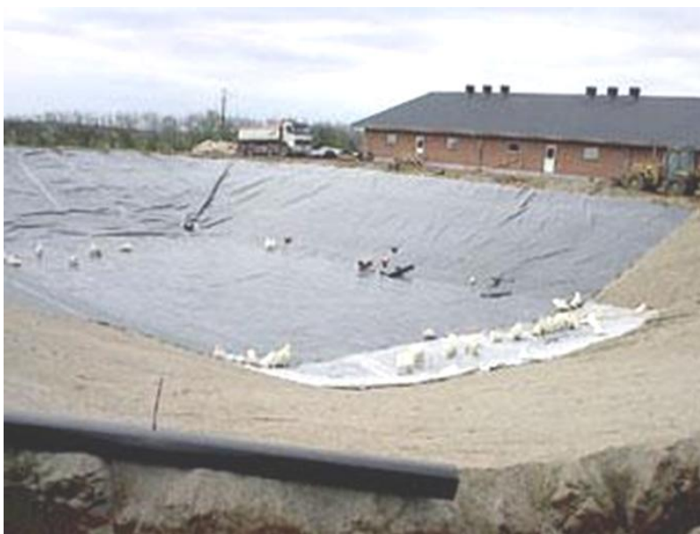
Рисунок 1 – Монтаж гео-пленки в лагуне
