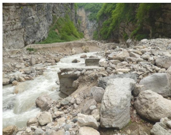
Рисунок 2 – Разрушенный селом нижний мост через р. Псыгансу (фото ФГБУ «ВГИ»)
